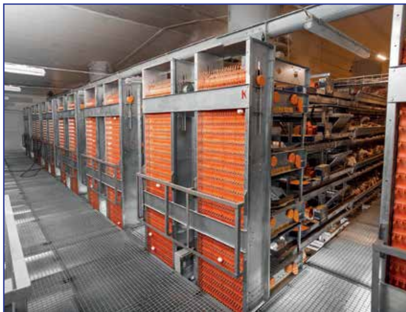
2-й этаж 8-ярусного оборудования Univent фирмы «Биг Дачмен»
