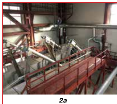
Рис. 2: а) узел механической очистки; б) узел обезвоживания осадков на ленточном фильтр-прессе
