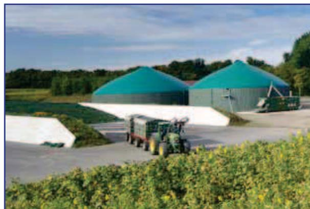
**Рис. 1.** В биогазовой установке идет процесс получения биогаза из имеющихся субстратов — отходов жизнедеятельности животных, силоса кукурузы, травяного силоса, свекловичного жома и др.
