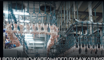
КАМЕРЫ ВОЗДУШНО-КАПЕЛЬНОГО ОХЛАЖДЕНИЯ
